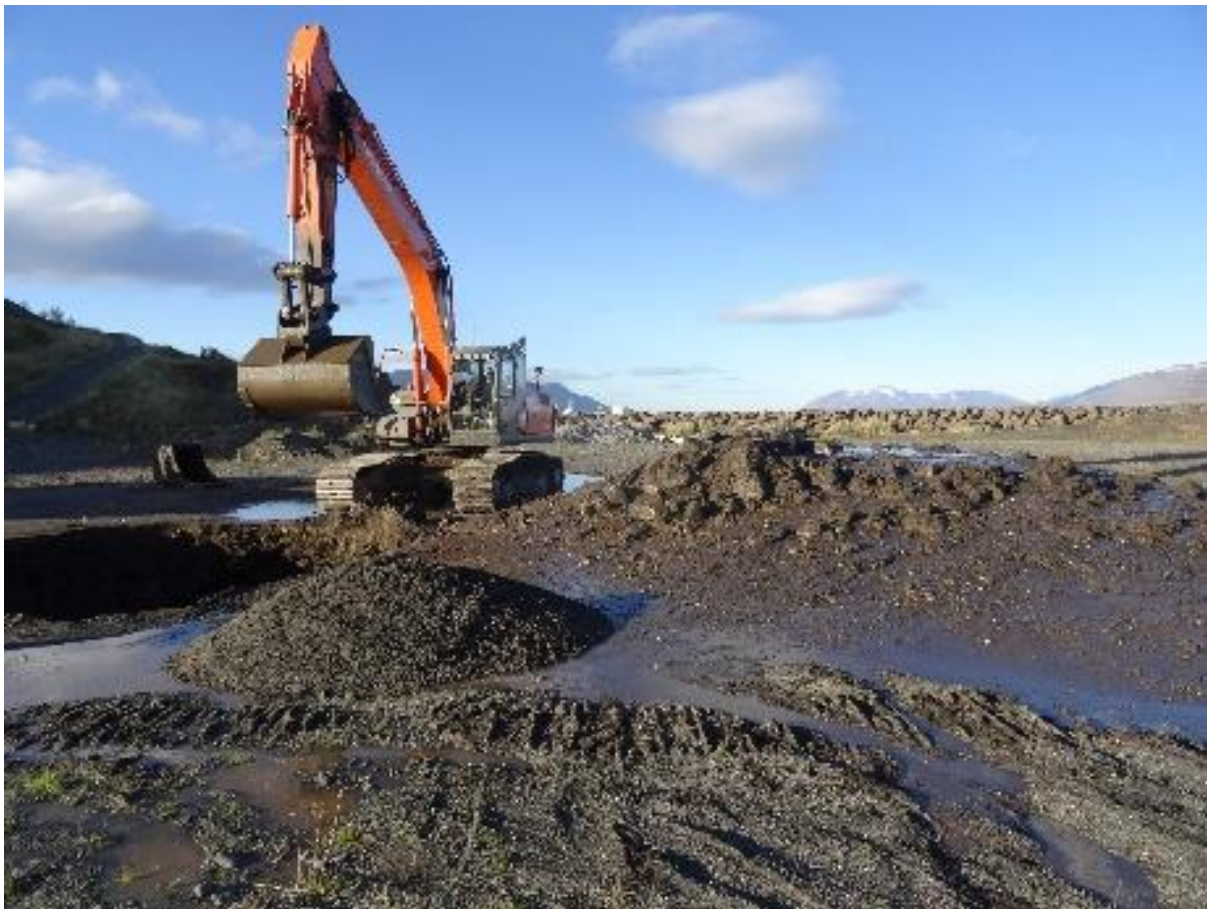
Mynd 3.7 Gröftur prufuholu. Mynd tekin í október 2015.
