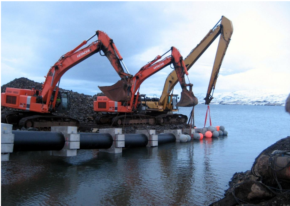
Mynd 3.6 Myndin er frá útdrætti núverandi útrásar í Sandgerðisbót árið 2012.
